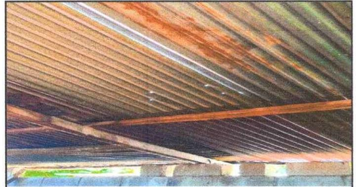
Foto 4: Se observa el deterioro de la estructura y lasminas portante en el modulo 2
